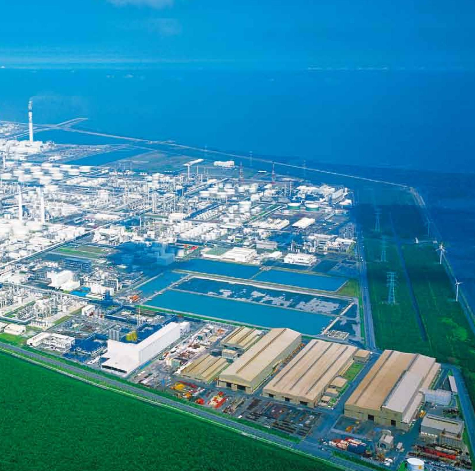
六輕計劃開發的麥寮區及海豐區，位於雲林縣最北端濁水溪出海口，南北長約8公里，沿海岸線向外延伸4公里多之外海地帶。絕大部分的土地平時均位於海平面以下，必須大舉進行填海造陸工程，以及地質改良鞏固基地後，才能作為建廠之用，填海造地的面積約2,255公頃，並且與沿海魚塢留有海水道隔離。
