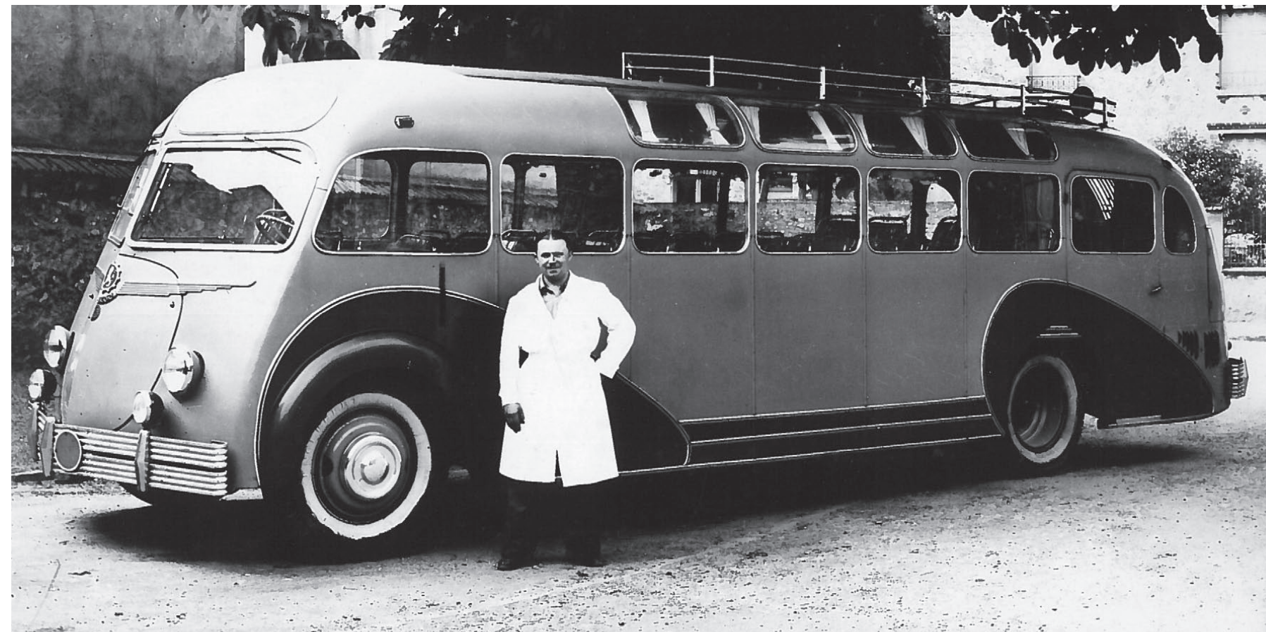
ISOBLOC. Présenté à l'occasion du Salon de Paris, en 1938, il a été le premier autocar européen moderne, conçu sur la base d'une structure autoportante et avec un moteur monté à l'arrière. En photo, le modèle de 1947.
